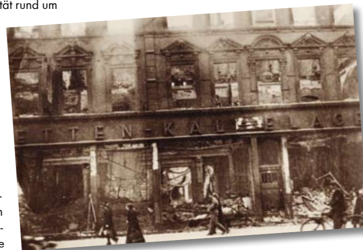
Das im Jahre 1945 teilweise zerstörte Bettenhaus wurde in den Nachkriegsjahren behelfsmäßig weitergeführt.
